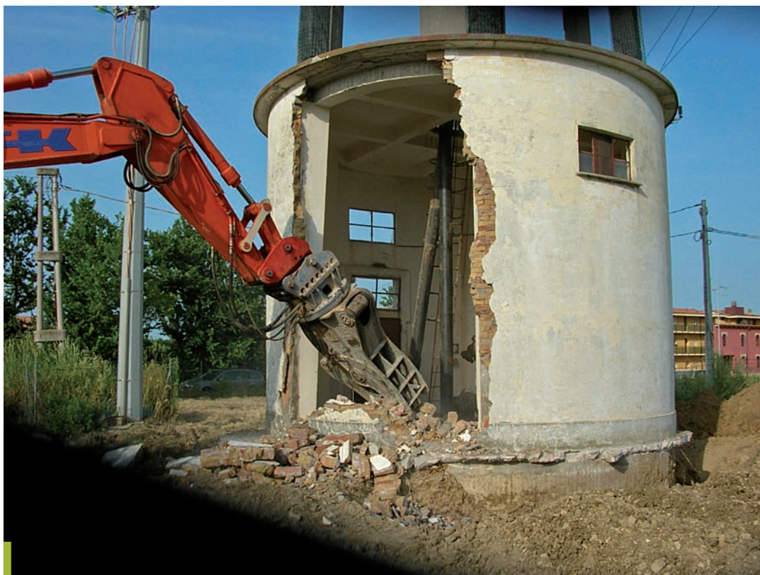
Le fasi di preparazione preliminare hanno previsto l'indebolimento della parte inferiore della struttura con un escavatore idraulico attrezzato con frantumatore idraulico. La rimozione delle tubazioni di adduzione dell'acqua si è resa necessaria per evitare che le stesse potessero rappresentare un impedimento alla caduta
