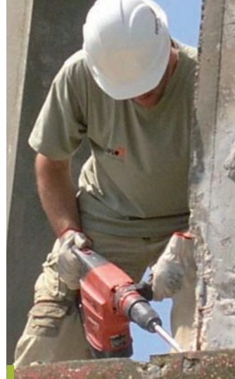
Per rispettare la direzione obbligata di caduta si sono armati tre dei sei pilastri di sostegno del serbatoio. In questa fase si è operato manualmente con l'impiego di utensili portando alla luce alcuni ferri di armatura
