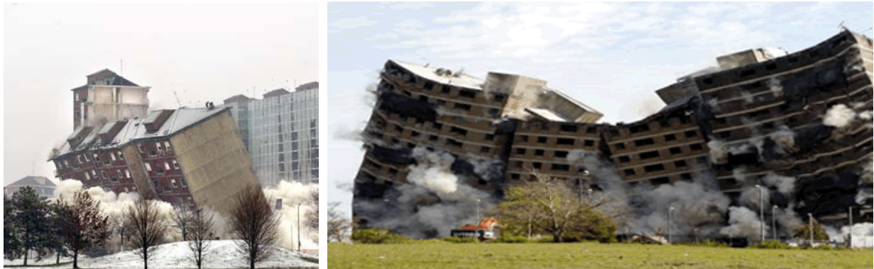
Figura 4. Demolizione con esplosivo di edifici multipiano ottenute con la tecnica del ribaltamento (foto di sinistra) e mediante implosione (foto di destra).
